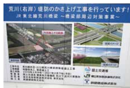
◀ JR東北本線荒川橋梁周辺の堤防かさ上げ工事の案内看板
