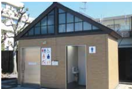
◀区内公園の公衆トイレ
