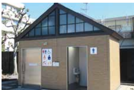
◀区内公園の公衆トイレ
