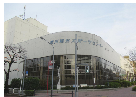
▲荒川総合スポーツセンター
