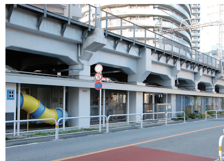
▲京成高架下が保育園として活用されている様子
