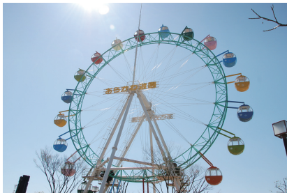
リ ニ ュ ー ア ル 工 事 の た め 現 在 休 園 中 の あ ら か わ 遊 園
