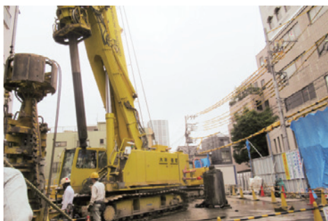
▲(仮称)日暮里活性化施設の工事の様子
