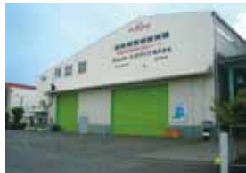
川越工場外観
