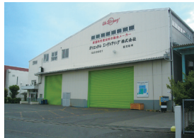
川越工場外観
